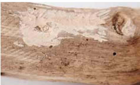
カラー図 30 パテのような充填剤が塗布された箇所の例（木材パーツ⑥）
