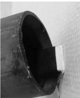
図21 金具と鋼管との間にゴムマットを敷き、鋼管が横方向にずれることを抑制する
