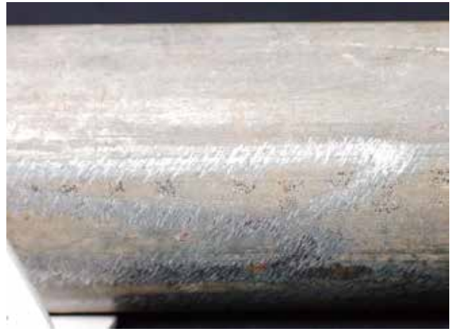
カラー図 19 鋼管表面の擦り傷またはひっかき傷の例（鋼管E）
