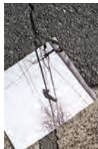
神戸市の路上・電線点検作業(2016年) ※引用資料:人と防災未来センター蔵
